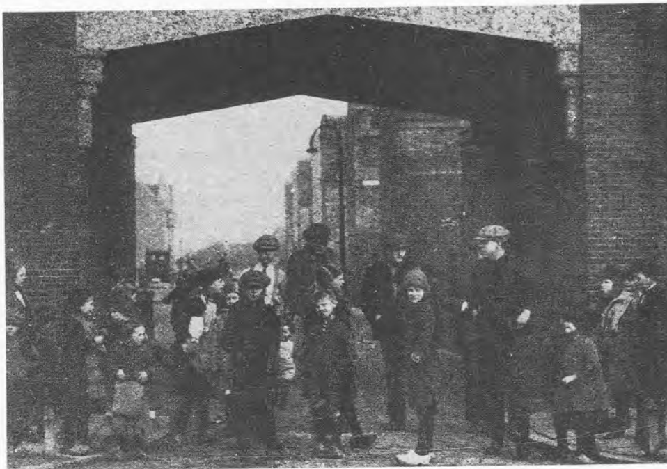
Gezicht op de poort van de Framboosstraat 1926. Bron: Gemeentelijke Archiefdienst Utrecht.
