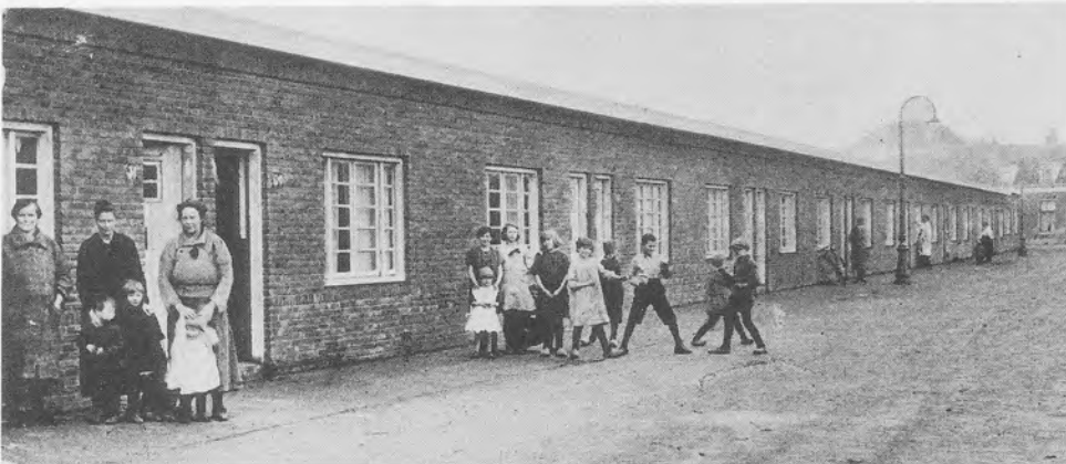
Gezicht op de Lijnweg (deel van de buitenring van het complex Kerkweg) in 1927. Bron: Gemeentelijke Archiefdienst Utrecht.
