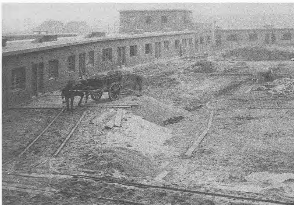
Het Houtplein in aanbouw. November 1924, twee maanden voor oplevering. Bron: archief Stichting Volkswoningen, Gemeentelijk Archief Utrecht.
